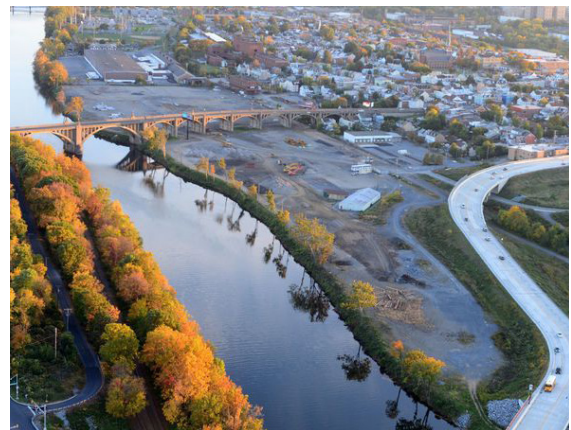
Vía de acceso por el puente de Tilghman Fuente: The Morning Call, “Construction will Soon Begin on First Allentown Waterfront Buildings”
