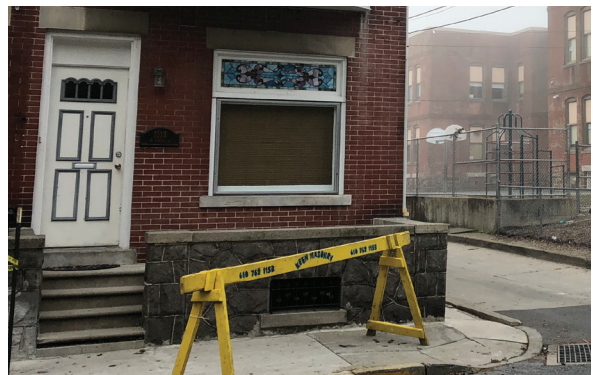
Reparaciones en la calle
